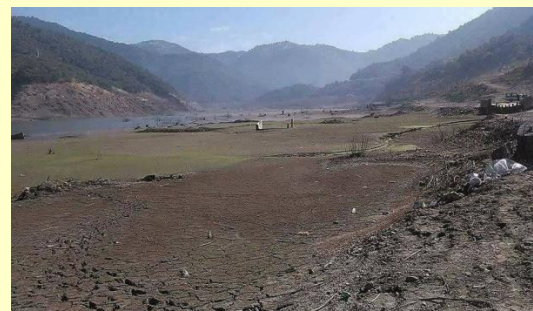
Fig. 3. Sécheresse, le barrage Taksebt à sec- novembre 2017 (Images : Source : Internet)
